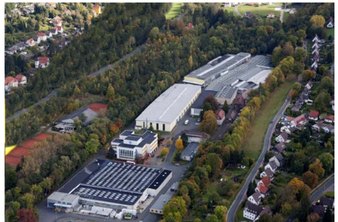
Hauptwerk der Firma Piller in Osterode
