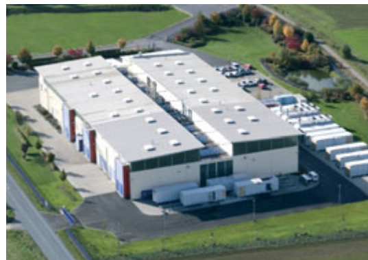
Montage & Prüfeinrichtung, Bilshausen
